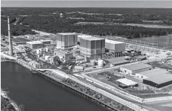
Centrale nucléaire de Brunswick, Caroline du Nord – Source : Duke Energy.
