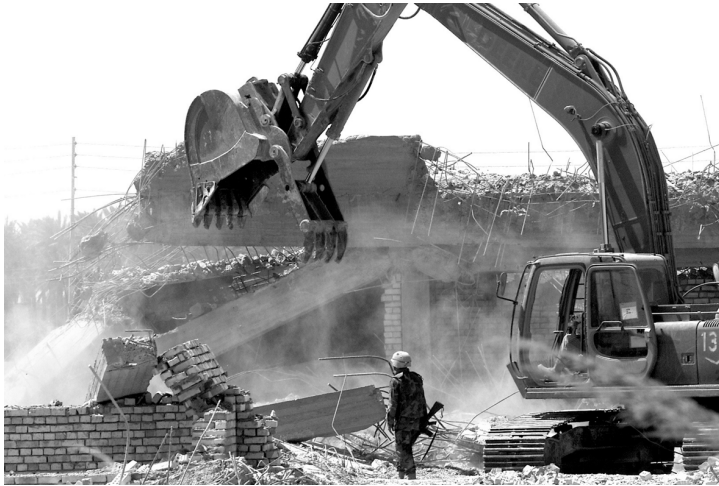
Imitation des procédés de l'armée israélienne en Palestine : une pelle mécanique américaine détruit une maison dans la ville de Ramadi, à 90 km à l'ouest de Bagdad.
